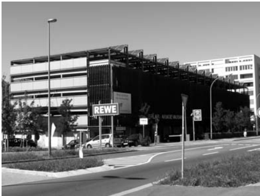
写真3 屋根にソーラーを設置した駐車場
