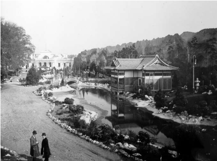
図9 平和園（水亭の背面は風景を描いた高壁）
