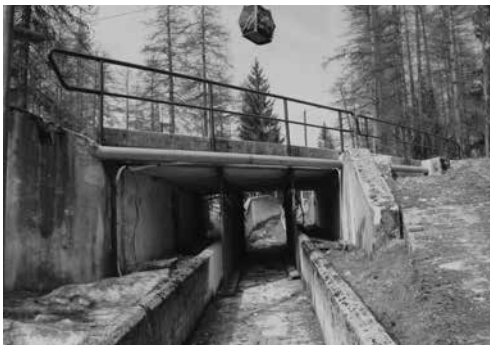
写真4 道路の陥没防止のためにトラック内に建てられた支柱 2020年2月筆者撮影
